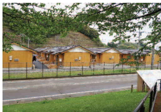
球磨村グラウンド仮設団地。「熊本型デフォルト」と呼ばれる。ゆとりがあり基礎はRC造の木造仮設
