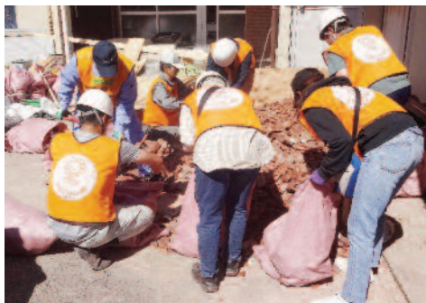
強風で落ちた屋根瓦の撤去作業（館山市）
