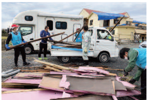
廃材仮置き場への搬送作業（南房総市）
